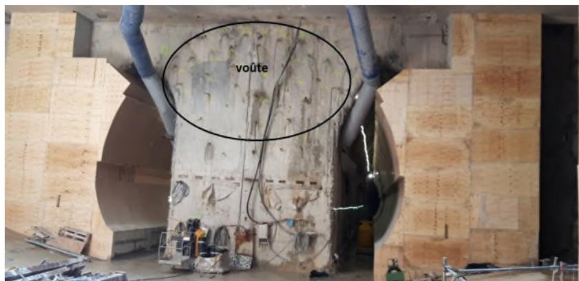
Le chantier se prépare actuellement à creuser la voûte de la galerie souterraine (voir partie rouge sur le schéma au verso de page). Pour ce faire, des travaux préparatoires sont en cours. Ils consistent à remblayer l'espace en fond de puit pour pouvoir créer une plateforme au niveau de la voûte. Ces travaux vont se dérouler jusqu'à la fin de la semaine prochaine.
