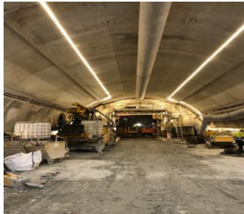
Nous avons également entamé l'excavation de la contre-voûte (partie inférieure de la chambre souterraine). Cette opération entraîne une intensification de l'activité (creusement et évacuation des déblais) y compris la nuit. Elle devrait s'achever fin octobre. Pour réduire les nuisances sonores observées dernièrement par les riverains, l'usage des engins bruyants est privilégié en journée et des rappels ont été faits auprès du grutier lors de la manipulation de la benne.
