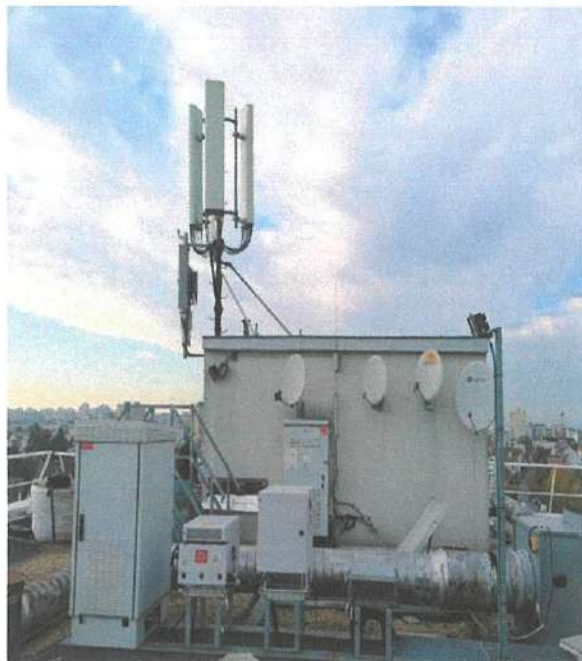
Vue de la terrasse S0 avant travaux
