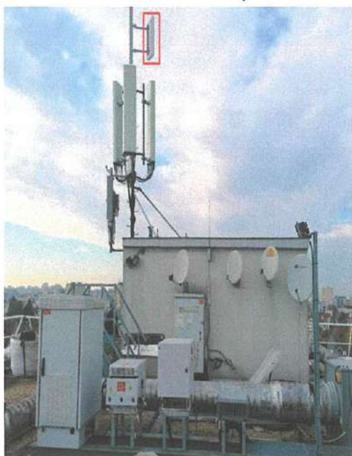
Vue de la terrasse S0 après travaux
