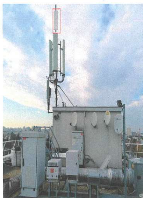
Vue de la terrasse S1 après travaux
