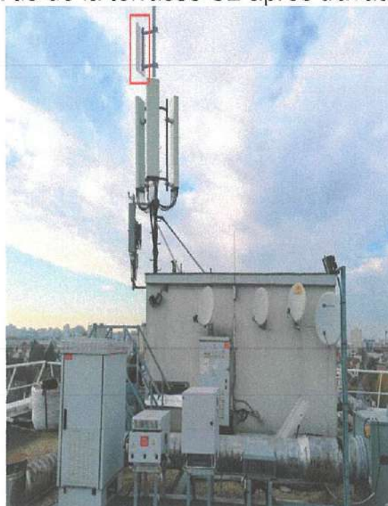
Vue de la terrasse S2 après travaux
