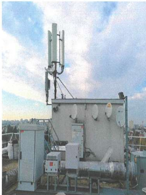
Vue de la terrasse S1 avant travaux
