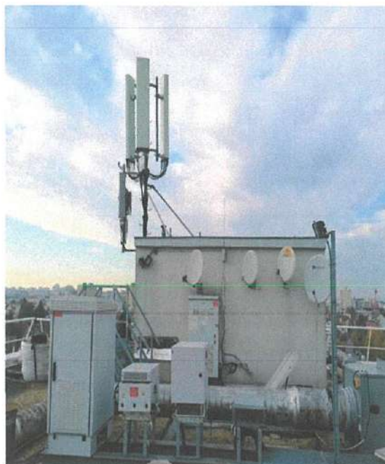
Vue de la terrasse S2 avant travaux
