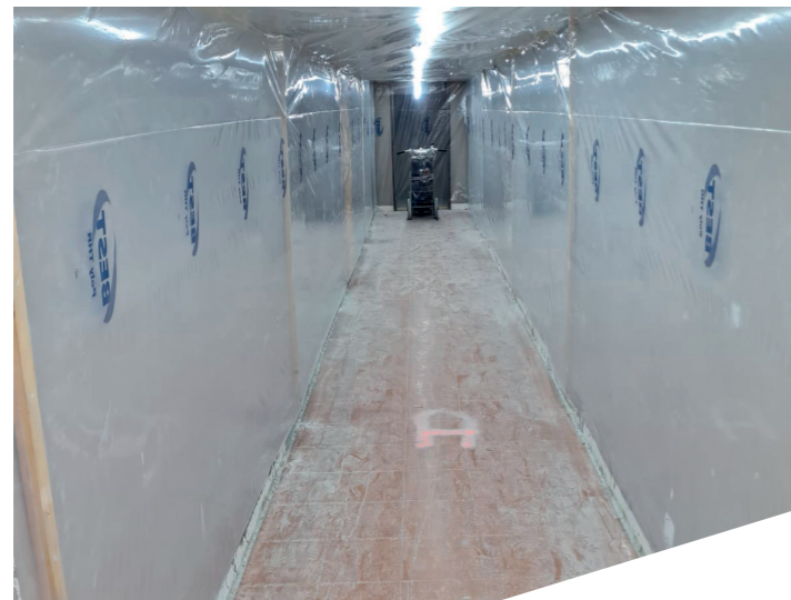
Chantier de désamiantage en milieu hermétique et confiné
