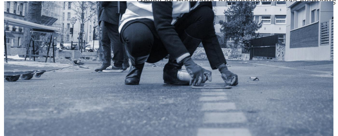
Marquage au sol des futurs implantation
