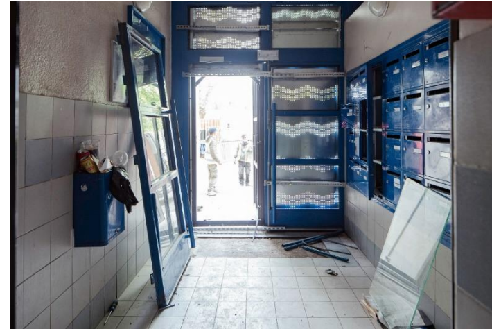
La dépose soignée des matériaux de second œuvre pour les besoins de la gestion courante du patrimoine de SSDH
