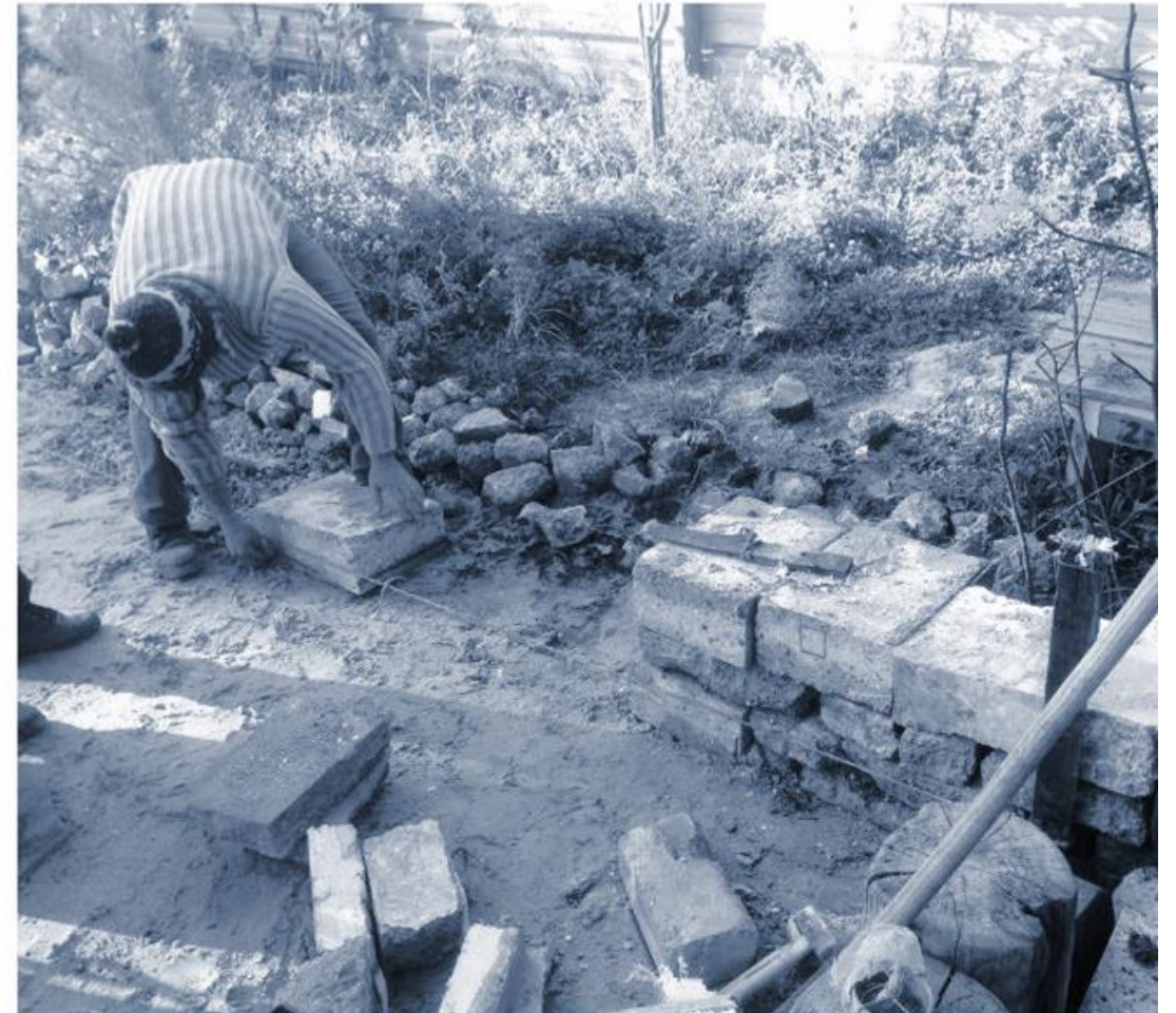
Chantier d'aménagement de la plateforme - Création du jardin
