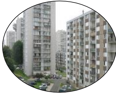
1. Déconstruction sélective MOA : Seine-Saint-Denis Habitat
